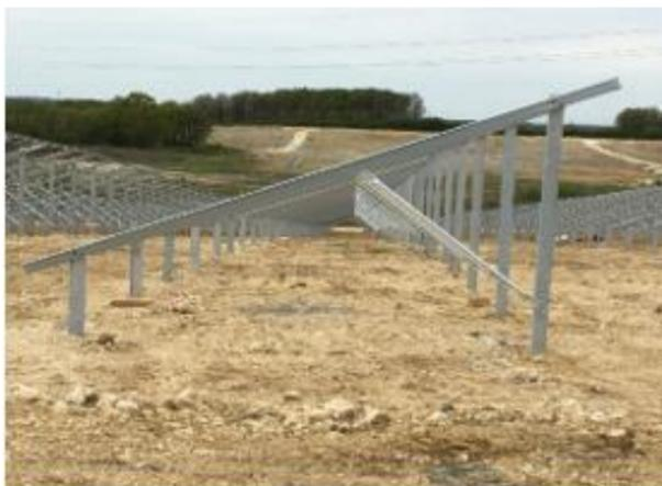
Photo 66 : Exemple d'une structure porteuse complète avant mise en place des panneaux
