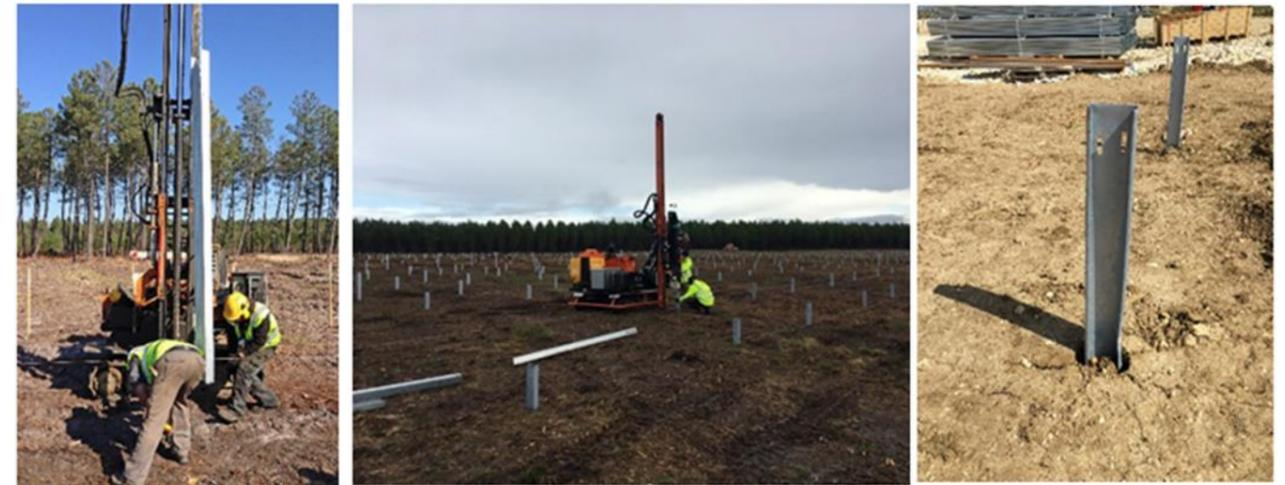
Photo 64 : Exemples de mise en place des pieux battus sur les chantiers URBASOLAR
